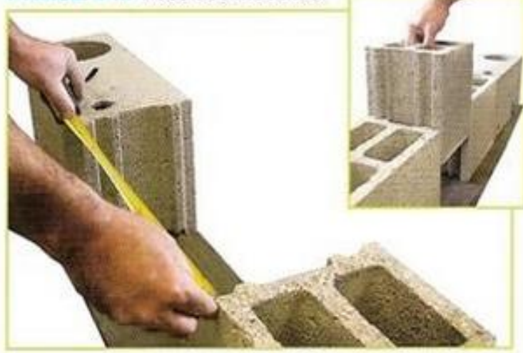
PHASE V /// Pose des modules
